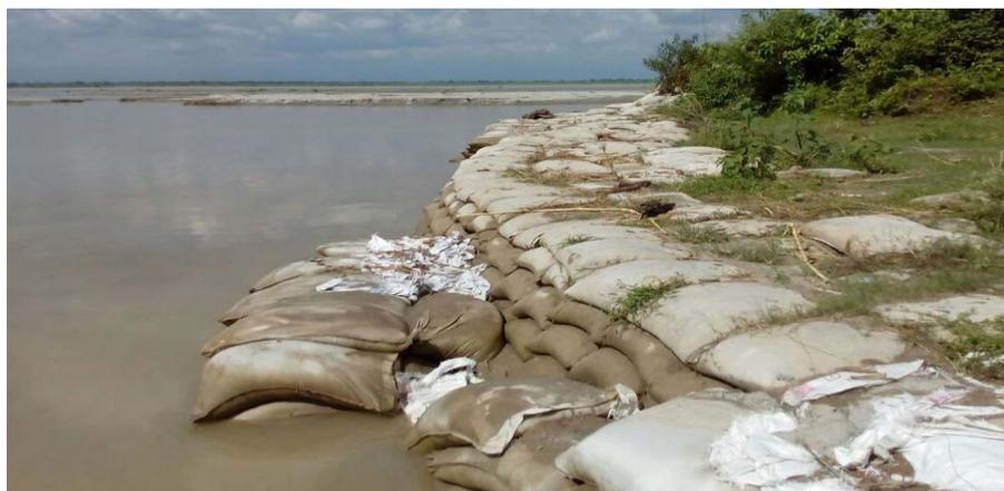
Gambar 1.3 Bangunan pengaman pantai dengan susunan geobag
