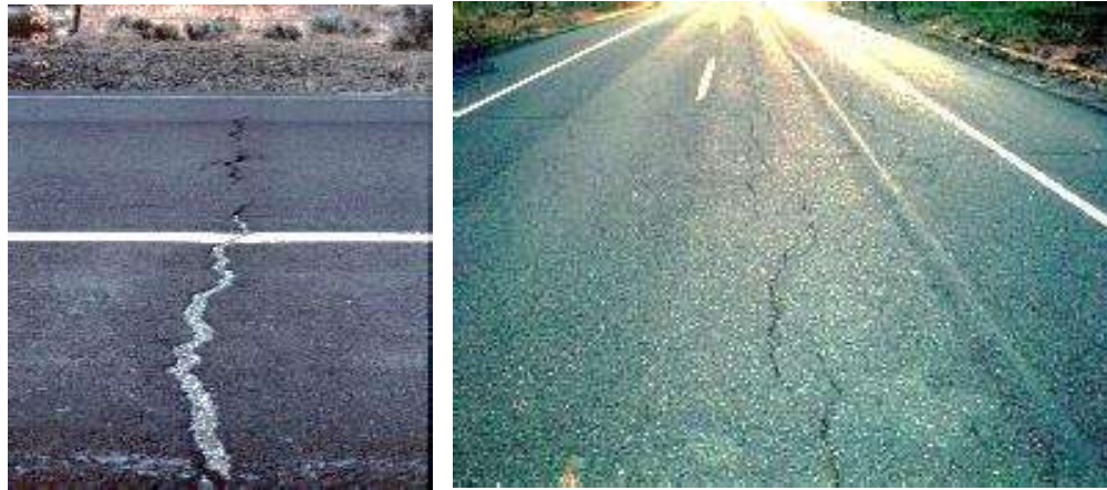
Gambar 2.7 Retak Memanjang dan Melintang (Sumber : Hafid, 2013)
