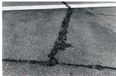
Gambar 2.6 Retak Reflektif Sambungan ( Joint Reflection Cracking )(Sumber : Bahlawant, 2011)
