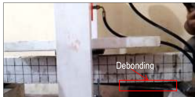
Gambar 4. 5 Kegagalan pada balok variasi pasir batu apung dengan perkuatan CFRP
