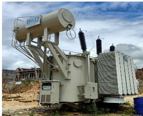
Gambar 2. 14 Trafo Daya (Pratomo et al., 2022)
