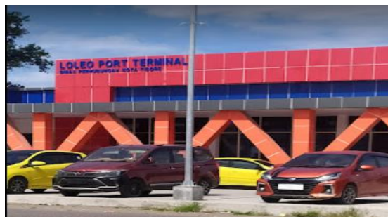
Gambar 3.1 Terminal penumpang pelabuhan Loleo
